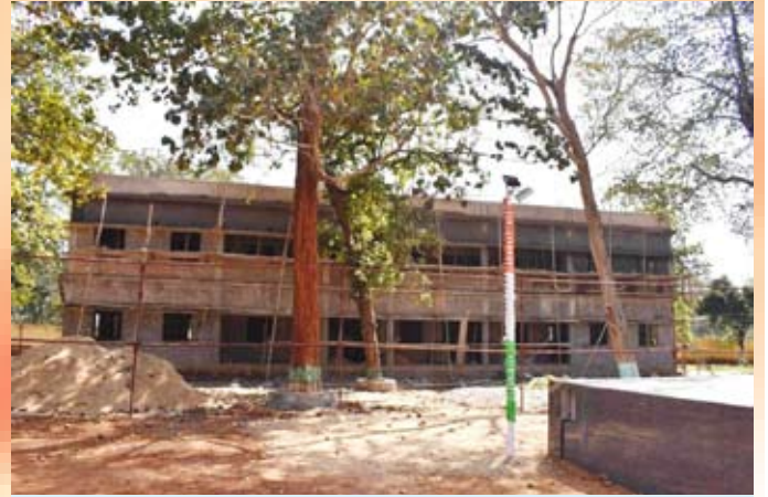
परिचालन रेंज दन्तेवाड़ा का निर्माणधीन प्रशासनिक भवन
