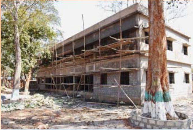
परिचालन रेंज दन्तेवाड़ा का निर्माणधीन प्रशासनिक भवन
