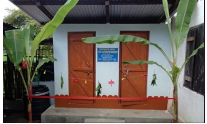
142 बटालियन, गोलाघाट (असम) द्वारा ग्रामीणों हेतु शौचालय का निर्माण
